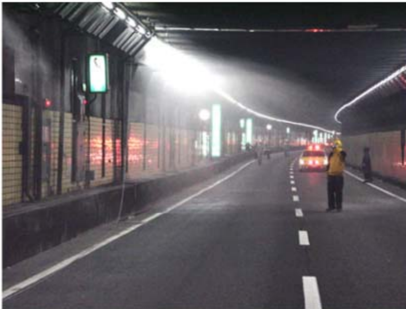
Inicio de prueba de descarga
